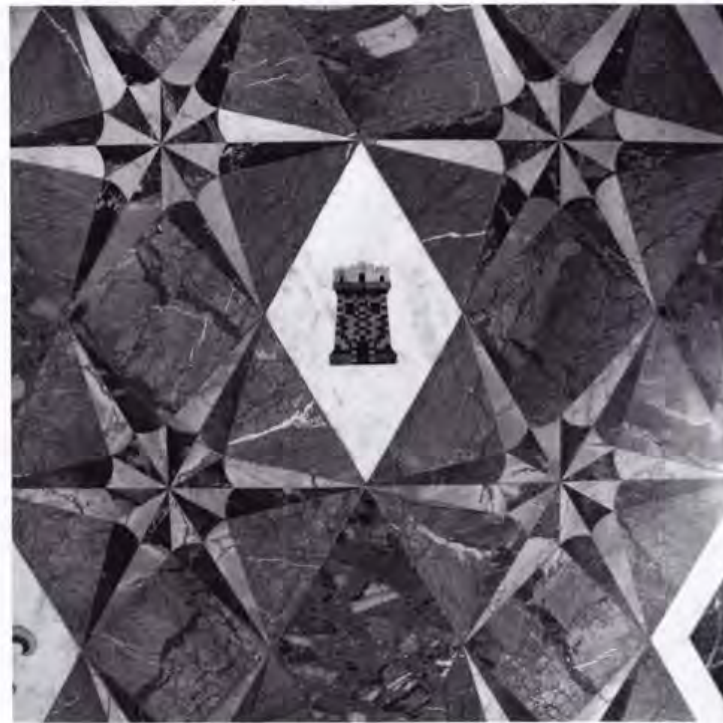
Fig. 3. Roma, convento dei SS. Bonifacio e Alessio, appartamento di Carlo IV e Luisa di Parma. Ambiente C, dettaglio con torre e gigli in giallo antico e rosso antico dentro losanghe di Carrara, altre losanghe in africano accanto a triangoli in portasanta, le stelle sono in giallo antico e bardiglio.
