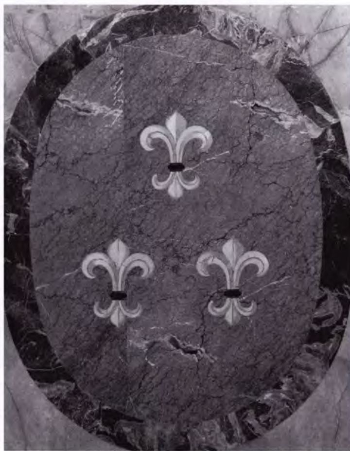
Fig. 7 - Roma, convento dei SS. Bonifacio e Alessio, appartamento di Carlo IV e Luisa di Parma. Ambiente B, dettaglio con tre gigli in giallo antico su fondo ovale in portasanta incorniciato di verde Alpi con quattro spicchi di giallo antico dentro fasce di botticino.
