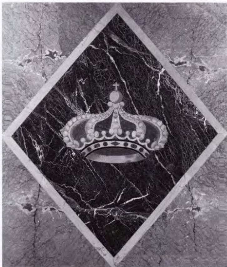
Fig. 6 - Roma, convento dei SS. Bonifacio e Alessio, appartamento di Carlo IV e Luisa di Parma. Ambiente B, dettaglio con corona reale eseguita in giallo antico e rosso antico su fondo a losanga in verde Alpi incorniciato di giallo antico con quattro spicchi triangolari in portasanta dentro fasce di botticino.
